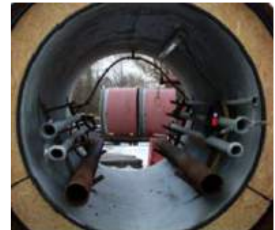
Sosteniment i revestiment definitiu microtúnel i instal·lacions interiors
