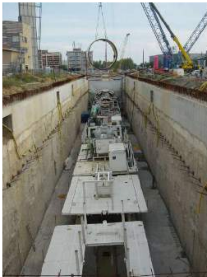
Hissat i descens peces tuneladora al pou introducció
