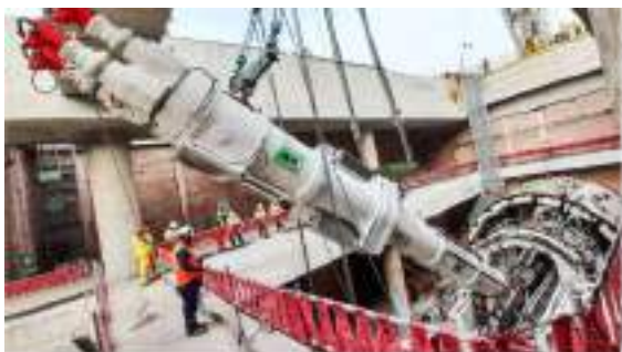
Muntatge tuneladora al pou d'introducció
