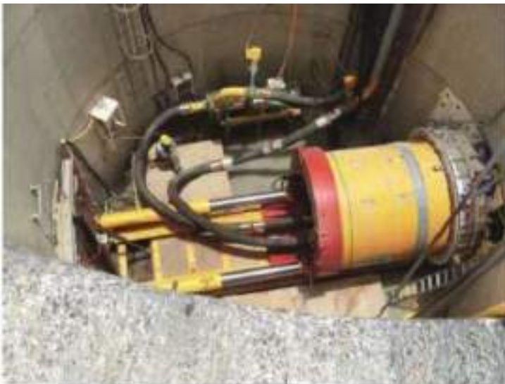
Sistema d'empenta sobre el mur de reacció
