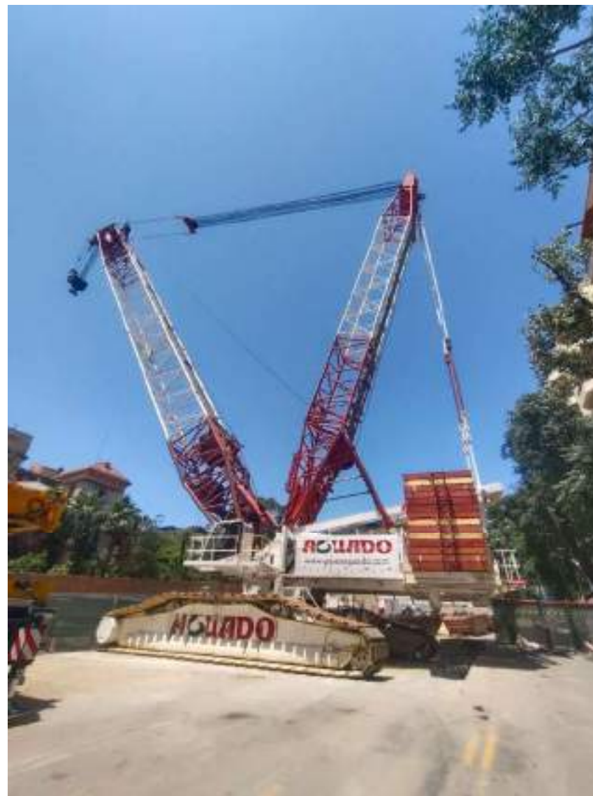
Grues especials i auxiliars pel muntatge de la tuneladora
